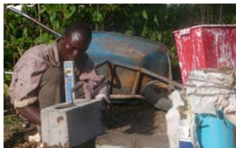
Fremstilling af de cementforstærkede lerblokke
